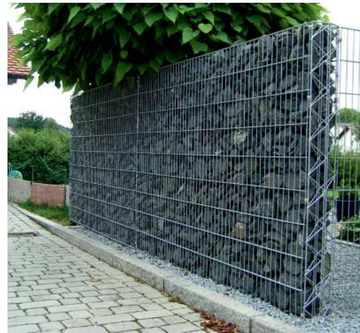
Сетка для габиона. Габионы – объемные формы из проволочной сетки, которые наполняются камнем или другими твердыми материалами. Их можно использовать как в виде ограждений, так и в качестве малых архитектурно-ландшафтных форм в планировании участка.
